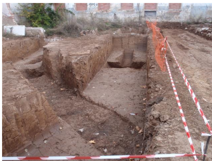
Vista general de la rasa 100 un cop finalitzada la seva excavació a la cota que apareix l'estrat 103.
